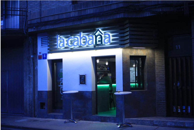
Foto de la fachada final después de la rehabilitación.
